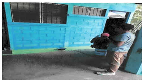
Foto 9: colocación de pintura en el establecimiento exterior
