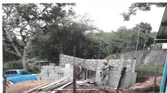
Foto 6: sustitución de puerta de cocina
