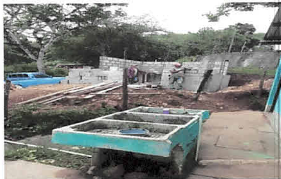
Foto 4: Mejoramiento perimetral de cocina con apoyo de estructura de concreto y metálica incluyendo elementos principales
