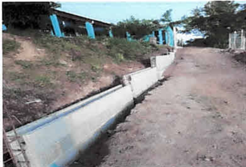
Foto 1: Reconstrucción de muro perimetral e instalación de malla
