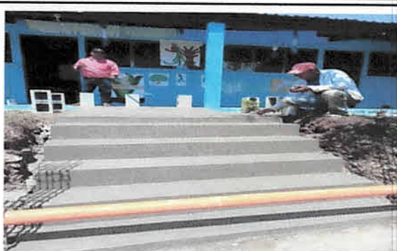
Foto 8: Remodelación de gradas de acceso principal, de concreto
